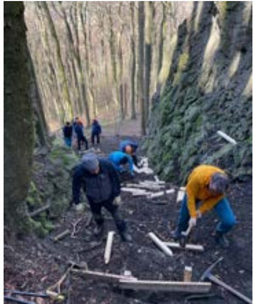
Fleißige Baumeister bei der Arbeit
